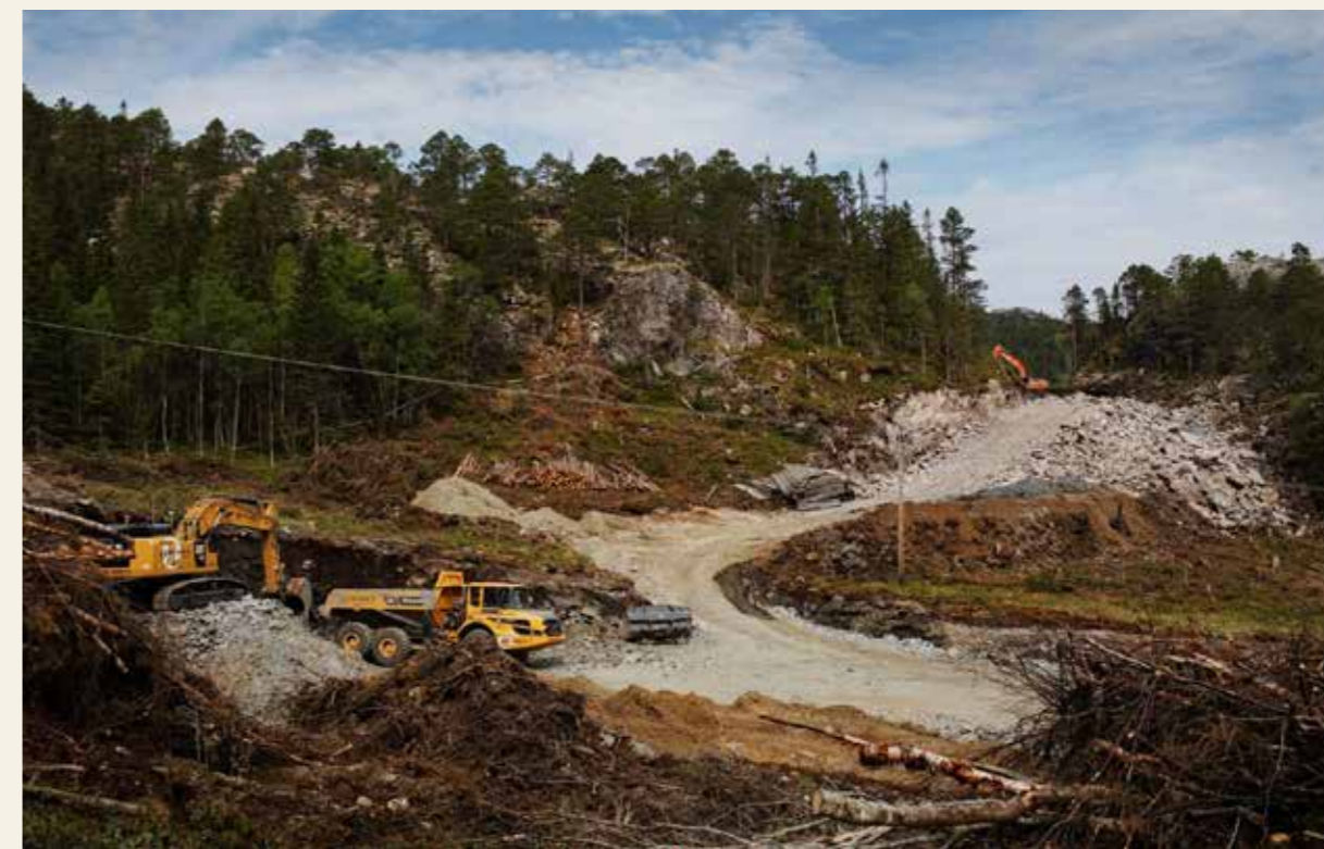
Anleggsmaskiner i 2019 i Hestdalen i Trøndelag i ferd med å bygge veien opp til vindkraftturbiner på Sørmarkfjellet. Konsekvensutredningen er fra 2005.
